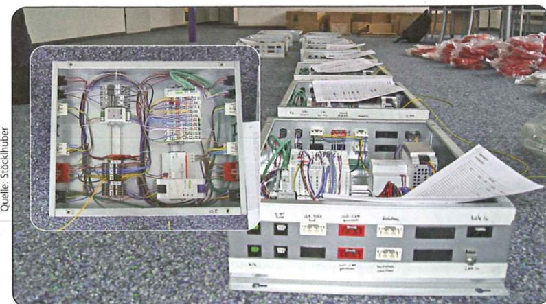
Bild 1: Ein Eindruck aus der Planungsphase des intelligenten Hauses im Januar 2010: Die Unterverteiler verschwinden später in den Wänden; einer davon wird auf der Light + Building sichtbar sein
