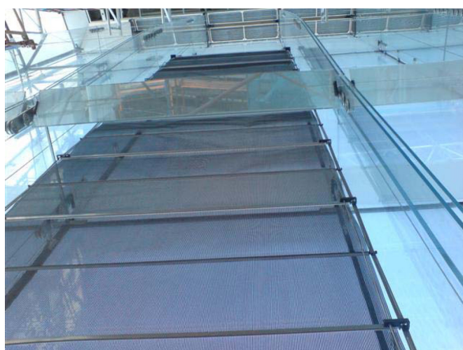
Sonnenschutzbehänge werden mit SMI-Antrieben hochgezogen
