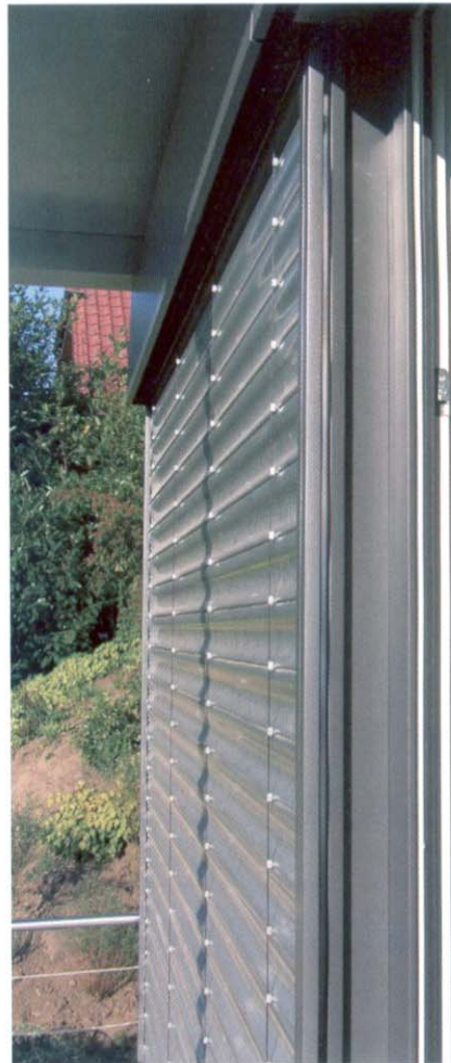
Die Raffstoren Typ Griesser Grinotex Sinus lassen ein vollständiges Schliessen der Lamellen zu.
