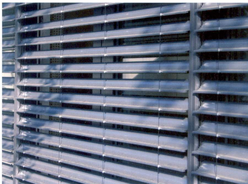
Der Synchronlauf der einzelnen Antriebsmotoren lässt eine exakte Positionierung der Lamellen zu.
