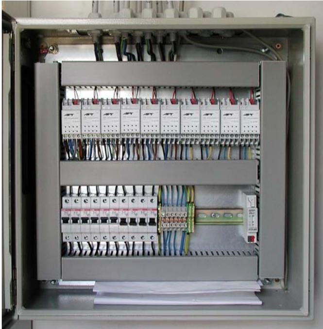
Bild 3: Steuerschrank mit SMI-Aktoren für bis zu 40 Jalousien
