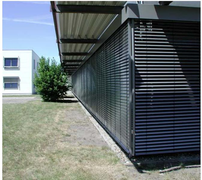
Bild 1: Die neuen Jalousien mit SMI-Antrieben und das Provisorium als Vordach beim Hauptgebäude von APT. Links das Nebengebäude für den Maschinenbau.
